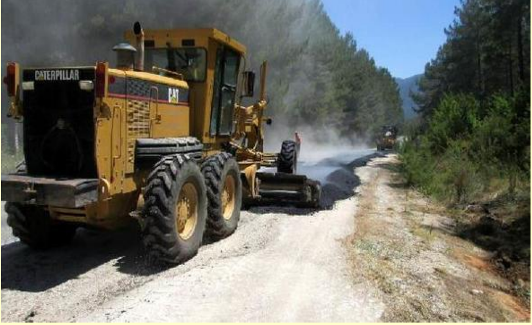
Görsel 198: Köy Yolu Genişletme Çalışması
