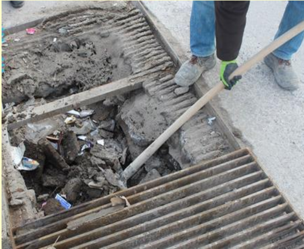
Görsel 63: Tıkanmış Kanalizasyon Gideri
