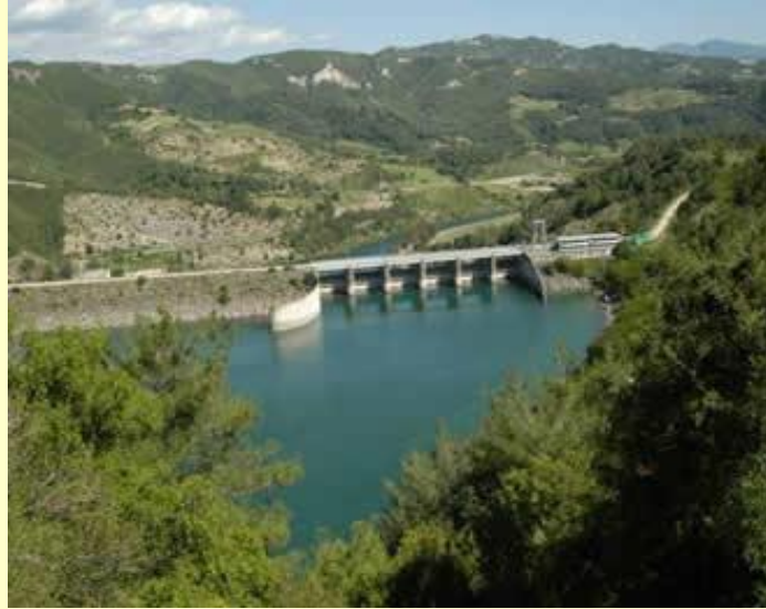
Görsel 166: Aslantaş Hidroelektrik Santrali
