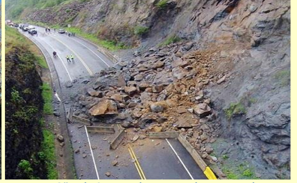
Görsel 104: Heyelan sonucu kapanan yol
